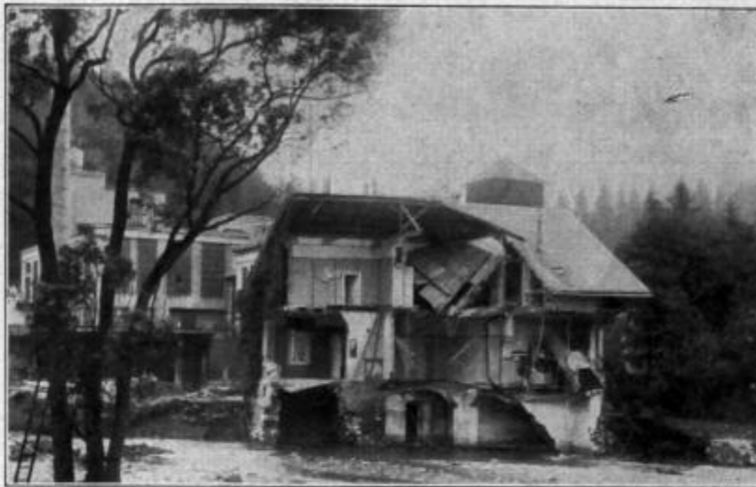
Von den Fluten zur Hälfte weggerissenes Wohnhaus
