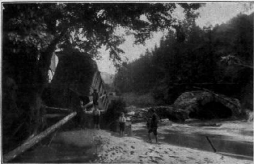
An der Kurfürst-Moriß-Brücke. Der obere Teil des Bogens ist in den Fluß gestürzt
