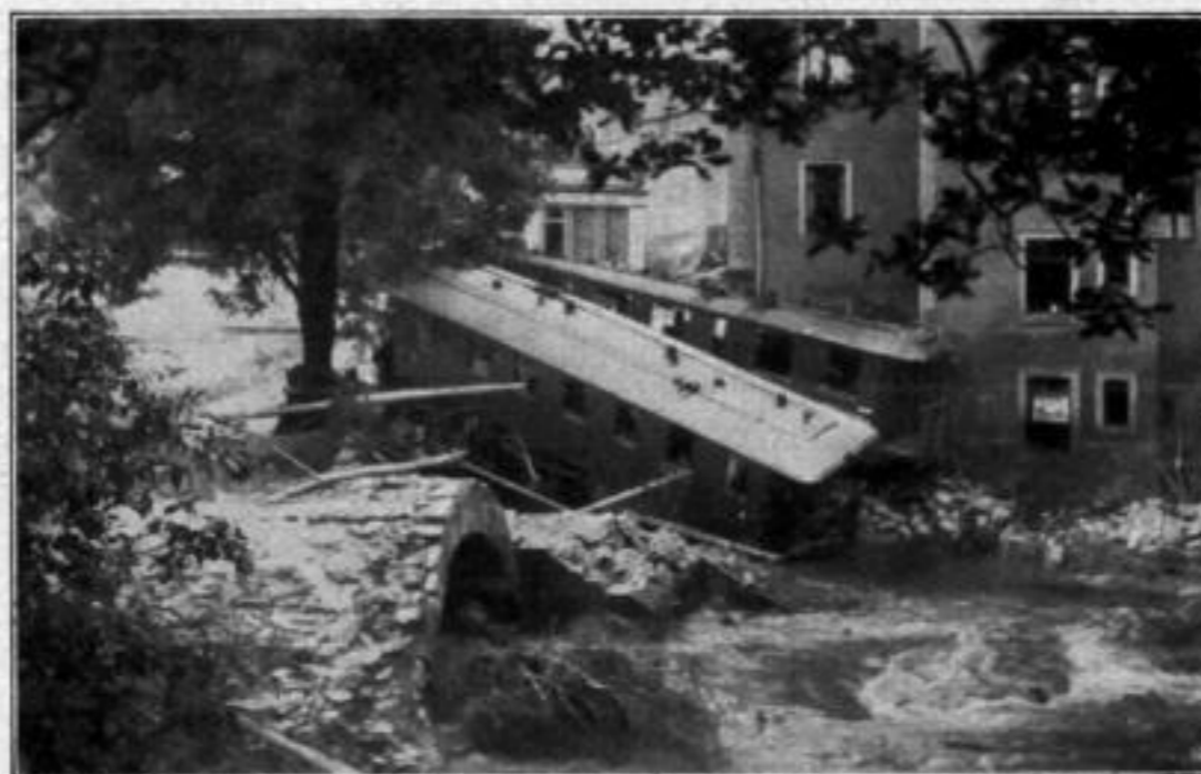
An der Kurfürst-Moriß-Brücke. Der obere Teil des Bogens ist in den Fluß gestürzt
