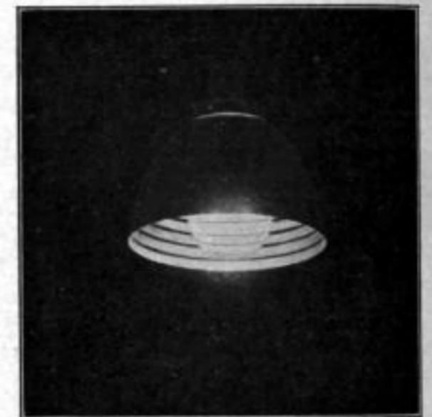
Abb. 8. Blende durch offene Tiefstrahler (Die glänzende Spiegelinnenfläche blendet stark)
