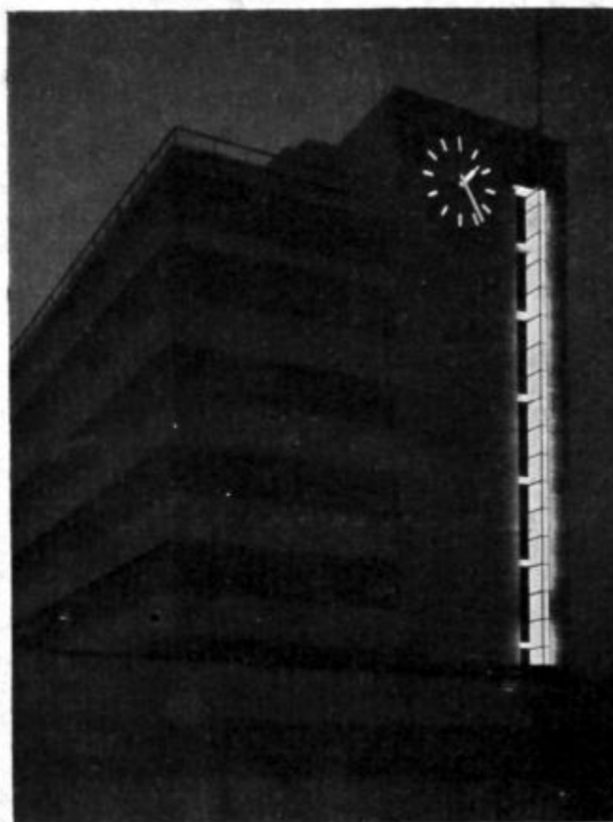
Abb. 2. Nachtbeleuchtung einer Turmuhr
