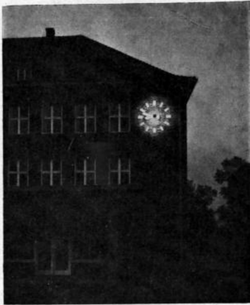
Abb. 4. Turmuhr mit Beleuchtung von der Mitte aus bei Nacht
