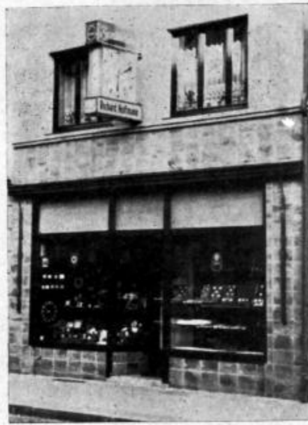
. . . und jetzt nach dem Umbau
