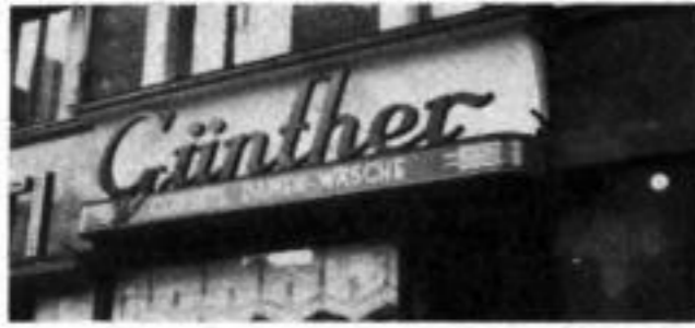
1. Ein ganz modernes Firmenschild: Rote Schrift, freistehend vor weißem, gewölbtem Untergrund. Hinter den Buchstaben wird die weiße Fläche von unten her beleuchtet.
