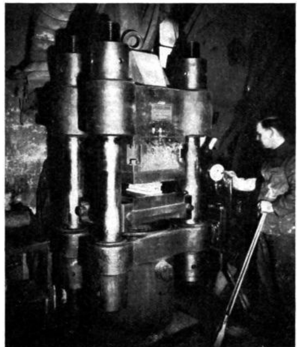
Abb. 1. Dubleeblock während des Druckschweißens.
