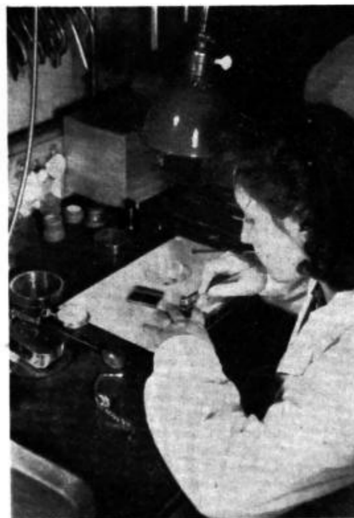
Bei der Armbanduhr muß die Zugfeder ersetzt werden
