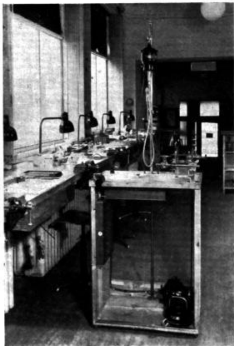
Am zweiten Drehstuhltisch ist der Hängemotor angebaut
