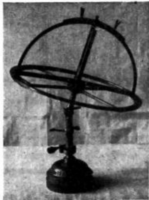
Universalinstrument nach einer vermutlich von Anich selbst her- rührenden Konstruktion
