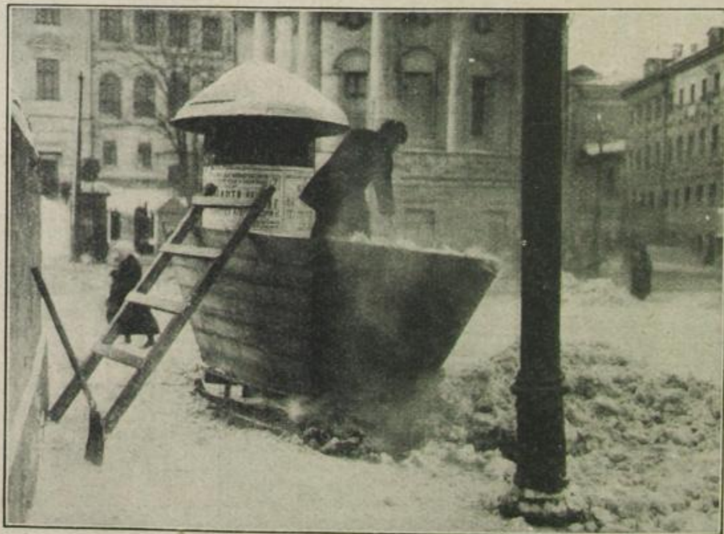
„Hier wird der ganze Schnee verbrannt.“ Schneebeseitigung durch Ofen in den Straßen von Moskau.
