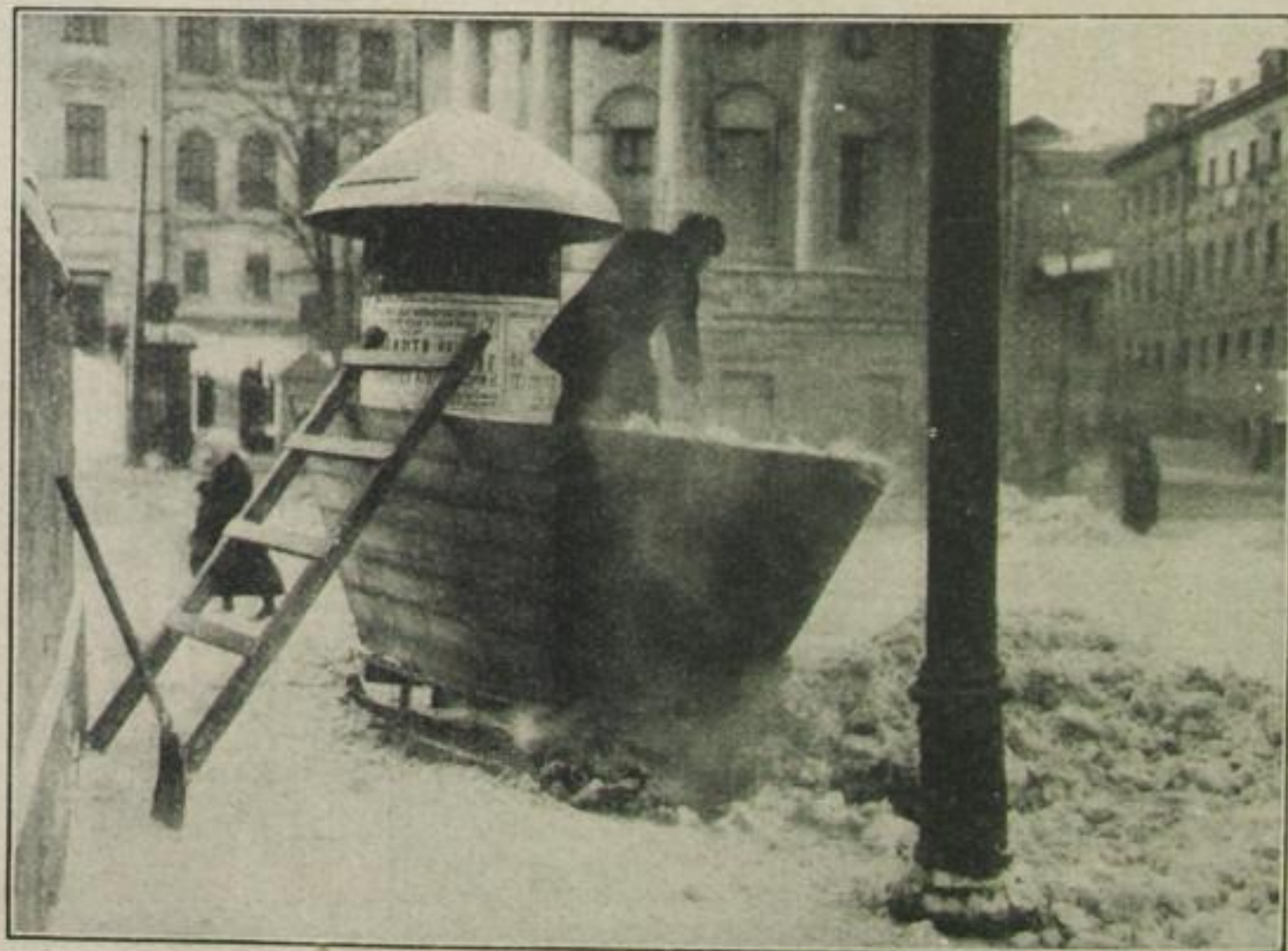
„Hier wird der ganze Schnee verbrannt.“ Schneebeseitigung durch Ofen in den Straßen von Moskau.
