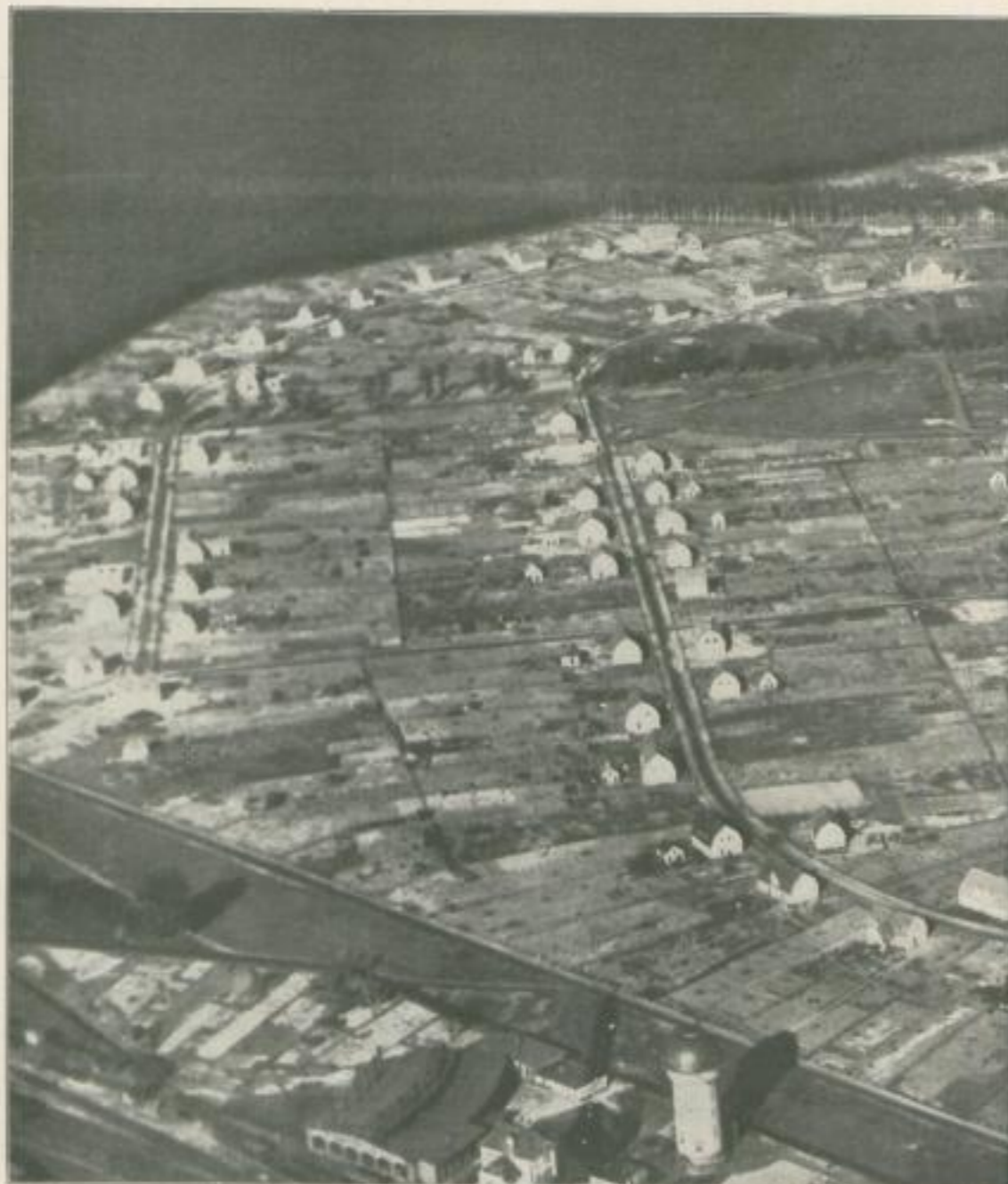
— — — einer mit Gärten und Siedlungshäusern verwandelten Flugaufnahme von der Siedlung Eckner, das an der Grenze
