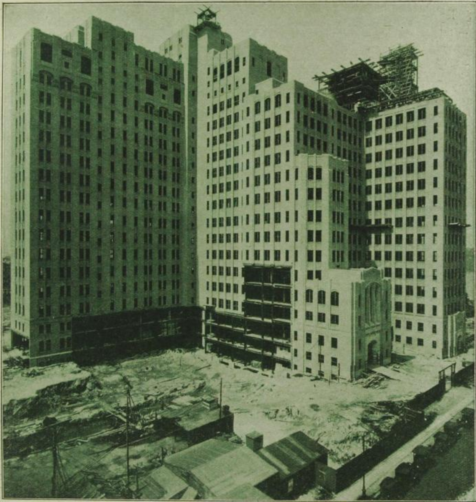
Nach weiteren vier Monaten: Der fast vollendete Bau. Die unteren Etagen stehen noch im Rohzustande.
