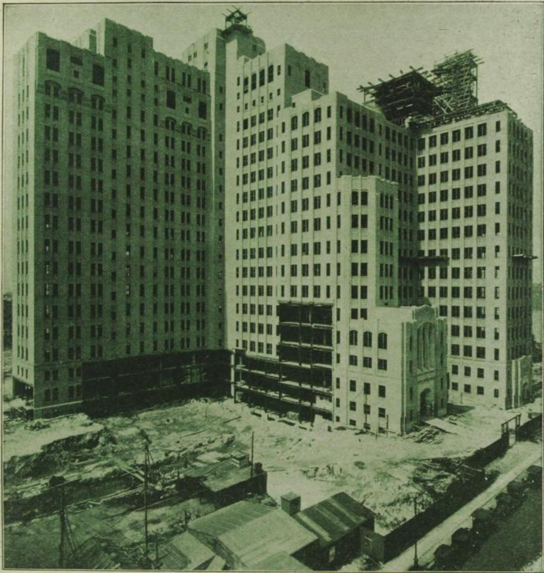
Nach weiteren vier Monaten: Der fast vollendete Bau. Die unteren Etagen stehen noch im Rohzustande.
