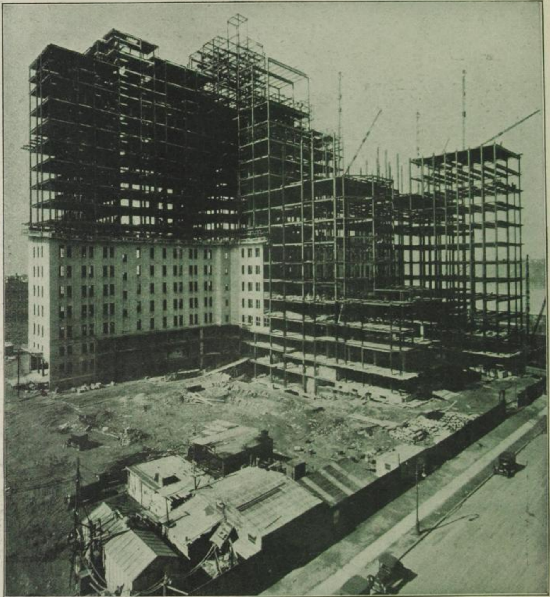
Ein Monat später: Die mittleren Etagen haben bereits ihre Fassade.
