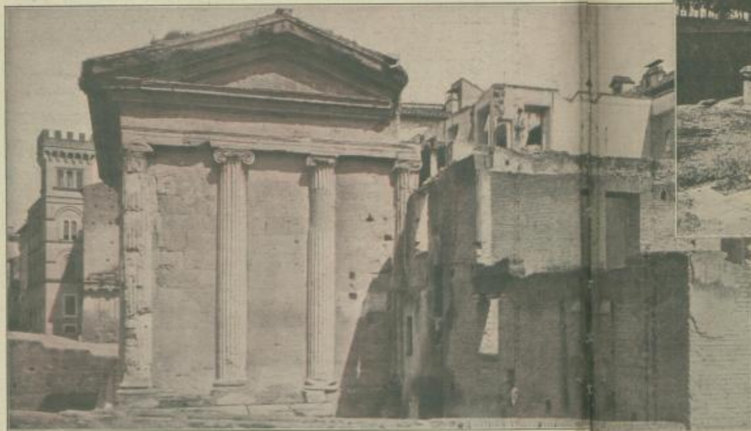
Tempel der Fortuna Virilis am Tiber in Rom, wie ihn bisher jeder Rom Am oberen rechten Dachrande ist ein Stück nebst Kranzgeisins herausgebrochen, um für die früher hier angesiedelten Mönche zu schaffen
