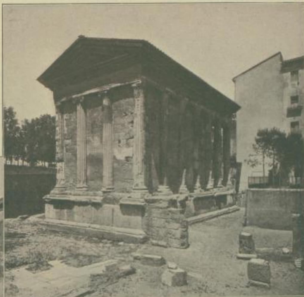
Aufnahme der staatlichen italienischen Bildstelle Wie der Tempel der Fortuna Virilis heute aussieht: Das fehlende Stück des Dachrandes ist sinngemäß ergänzt und die späteren Anbauten beseitigt wurden
