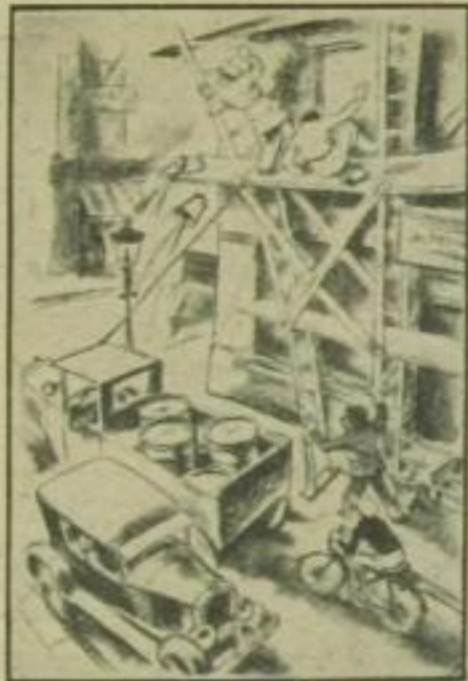
Achtung vor einem Baugerüst, da Stricke herabhängen können!
