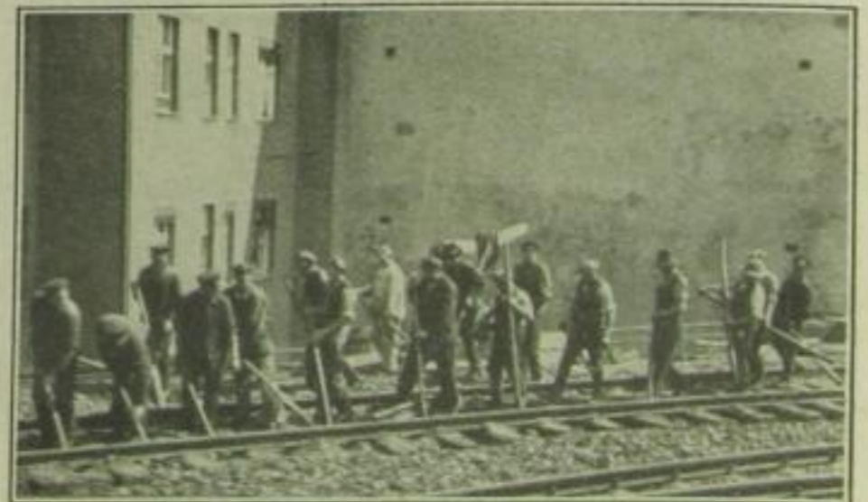
Ein Bild, ohne das die Berliner Stadtbahn nicht denkbar ist: Streckenarbeiter, die durch Hornsignale gewarnt werden, wenn der Zug sich naht.
