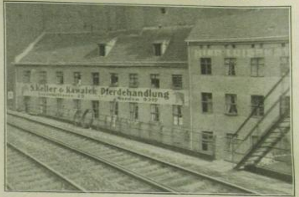
Zwischen Lehrter Bahnhof und Friedrichstraße sieht man hart am Gelände der Stadtbahn viele alte verwinkelte Berliner Häuser, wie sie für den Fußgänger auf der Straße nicht zu sehen sind.
