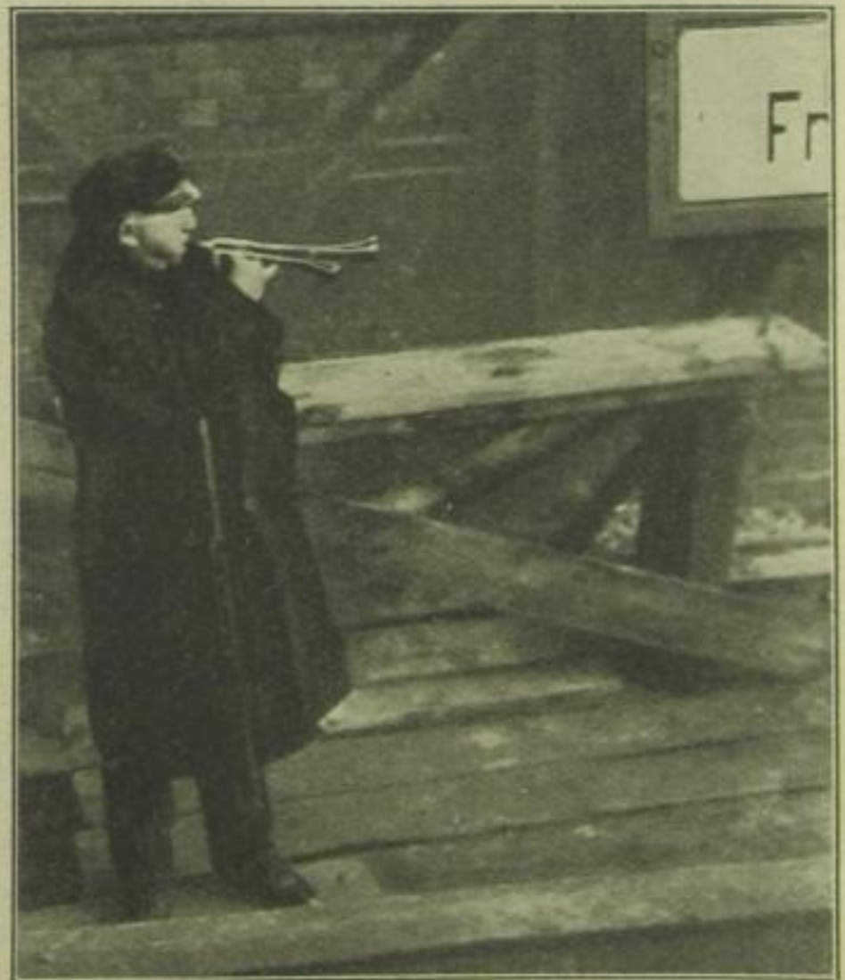
Stadtbahnstreckenwärter, der die Arbeiter vor dem herannahenden Zuge warnt.
