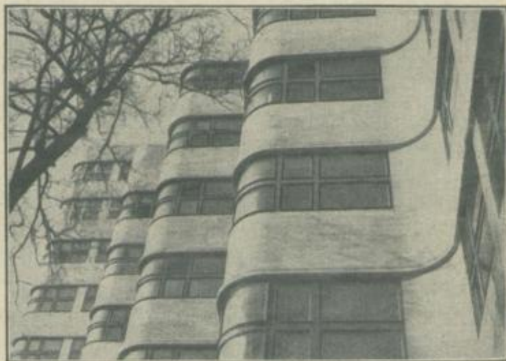
So war es ein „Treppenhaus“
