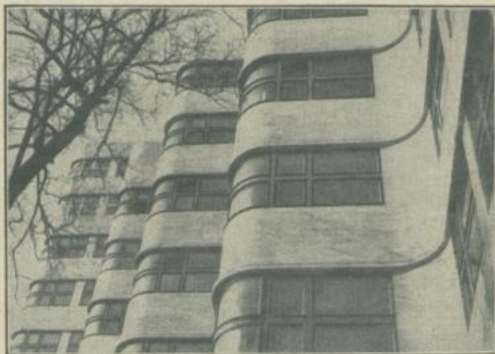
So war es ein „Treppenhaus“
