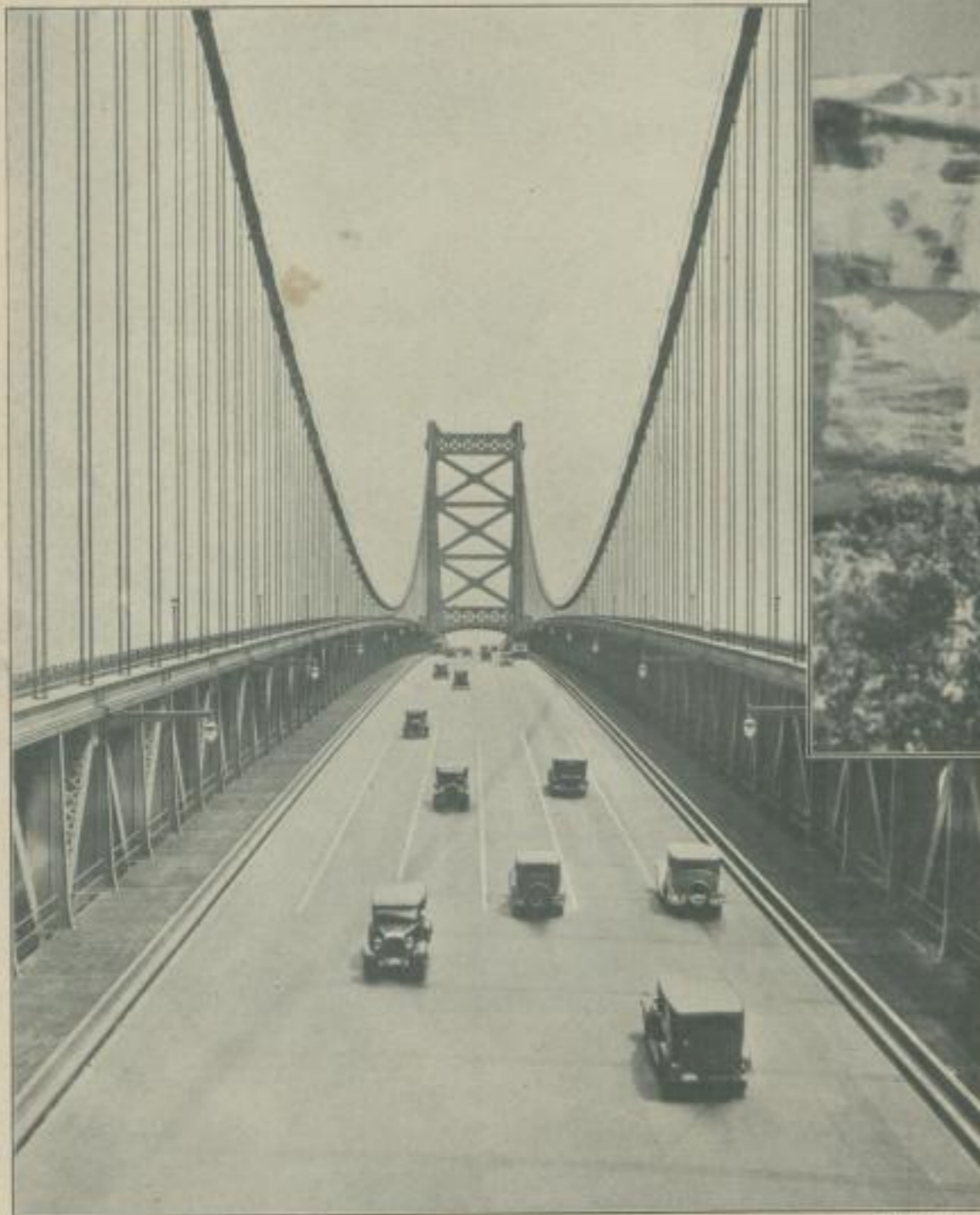
Eine Brücke, die zwei Staaten miteinander verbindet: Die Delaware-Brücke. Diese Brücke verbindet Philadelphia mit New York. Sie hat eine Länge von 1088 m. Ihre größte freie Stützweite beträgt 533 m.
