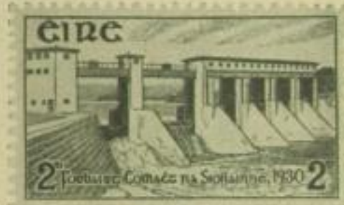
Das Channon-Kraftwerk in Irland, von elektrotechnischen Großfirmen Deutschlands erbaut (Irland: 2 Pence).
