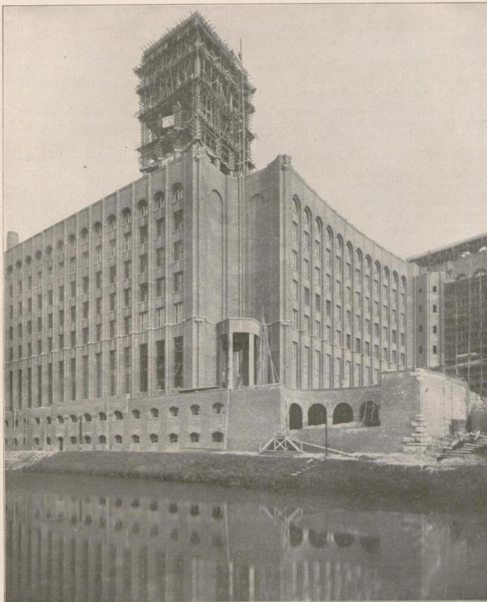
Berlin-Tempelhof: Das Ullstein-Druckhaus kurz vor der Vollendung. Hier sollen die Zeitschriften und Bücher gedruckt werden.
