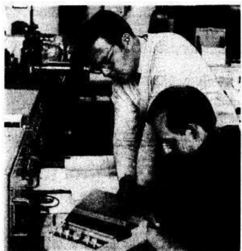
AM VOLLAUTOMATISIERTEN PRÜFSTAND für Doppelbackenbremsen arbeitet Student Wolfgang Riesel, seit Februar Ingenieurpraktikant der Sektion 16,4 StJ., als Mitglied eines Forschungskollektivs, das für die VVB TAKRAF Standardbremsen untersucht. Der Prüfstand wurde vom Leiter des derzeitigen Arbeitskollektivs, Dipl.-Ing. Wolfram Arndt (im Bild stehend), projektiert und einge-richtet.
