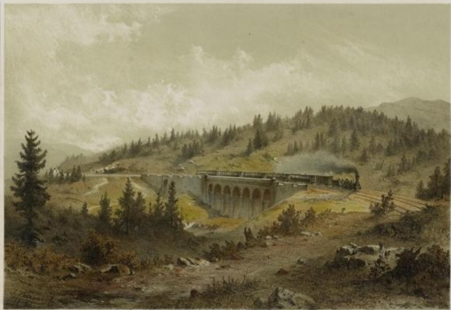
VIADUCT ÜBER DIE ALTE TRIESTER STRASSE BEI OBER LAIBACH.
