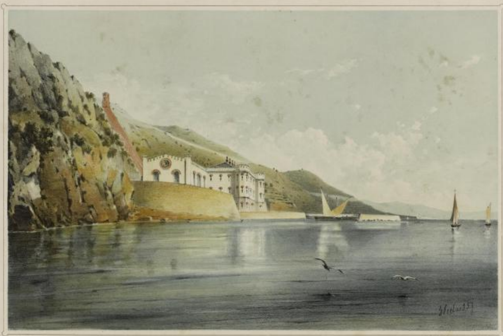
DAS MASCHINENHAUS DER WASSERLEITUNG DES AMERIKANISCHEN
